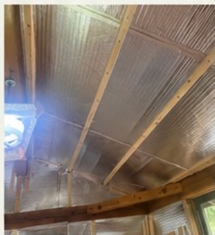
天井部分の施工
